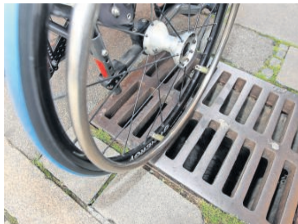
Die Räder des Rollstuhls bleiben in den Rillen eines Gullis leicht hängen.
